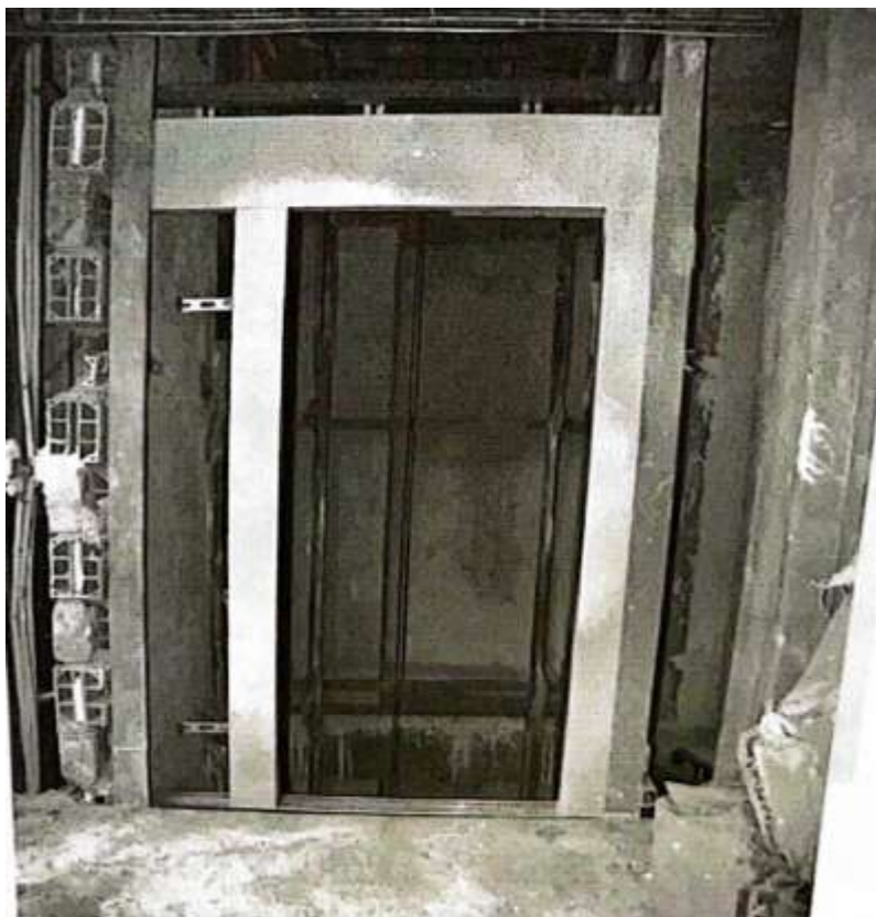
شکل ۲-۳۲ نصب قاب دور درب طبقه قبل از تکمیل کارهای ساختمانی جلوی ورودی آسانسور
