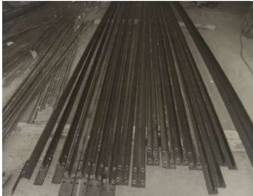
شکل ۱-۱۶ انبارداری غیر اصولی ریل ها
