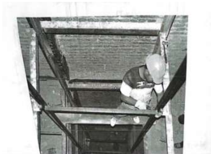
شکل ۱-۷۰ کنترل دهانه ریل توسط ساعت ریل (نبشی)
