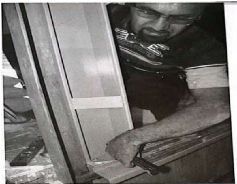
شکل ۲-۳۱ محکم کردن پیچ و مهره ستون قاب درب به روی آستانه
