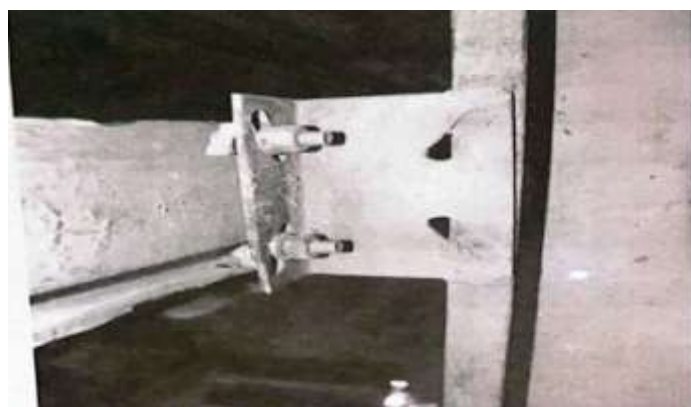
شکل ۱-۷۸ پس از تکمیل عملیات نصب براکتها و ریلها و سپس تمیز کاری ریلها پشت آنها را رنگ آمیزی کنید
