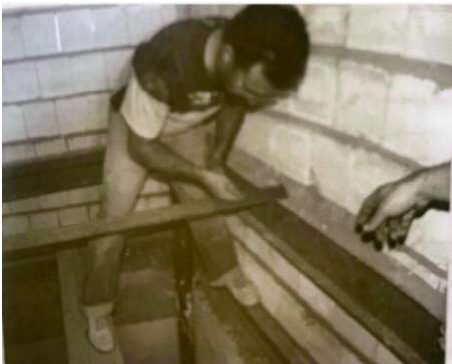
شكل ۱-۲۸ تنظيم محل سيم شاقول در انتهاي چاه نسبت به موقعيت براكت و يا ريلها
