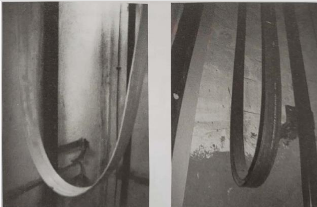
شکل ۶- تراول کابل پس از آویزان شدن در زیر کابین به شکل U در می آید.
