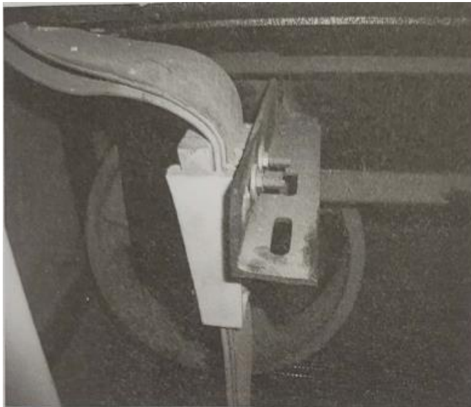
۵- تراول کابل توسط قطعات پلاستیکی محکمی به زیر کابین متصل می‌شود.
